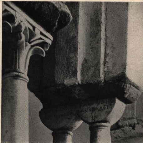
Fig. 18 - Chiostro predetto: particolare.
