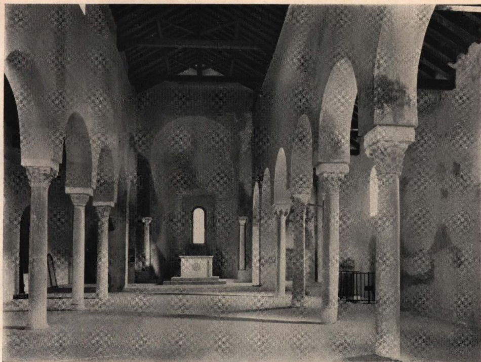
Fig. 146 - Interno della chiesa predetta.
