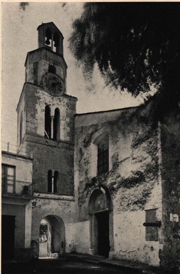
Fig. 162 - Campanile della chiesa di S. Giovanni in Pontone.
