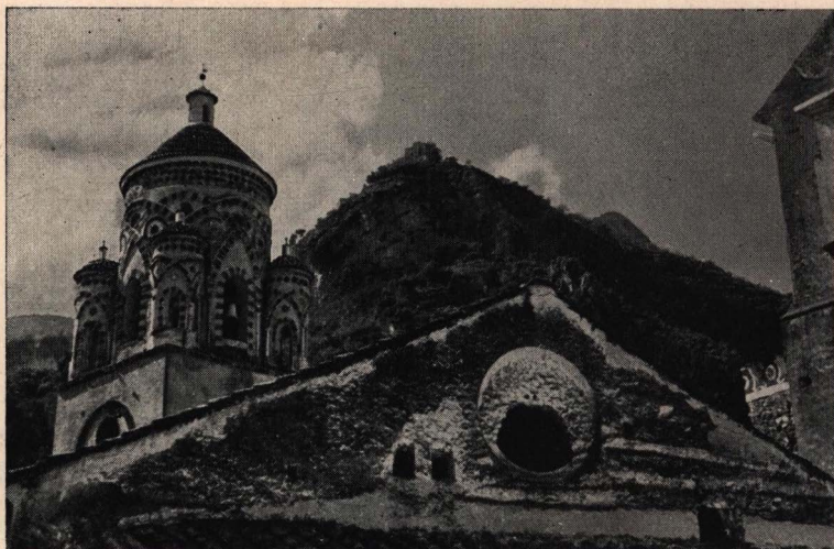
Fig. 37 - Duomo di Amalfi: cella del campanile e frontone orientale della basilica del Crocifisso. (fot. E.N.I.T.)
