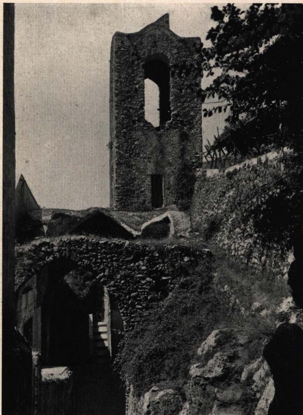
Fig. 163 - Chiesa di S. Filippo Neri in Pontone: atrio e campanile.
