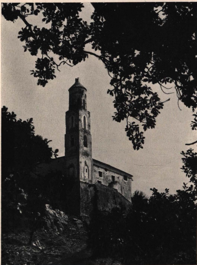
Fig. 174 - Campanile della chiesa di S. Pietro in Tovere.
