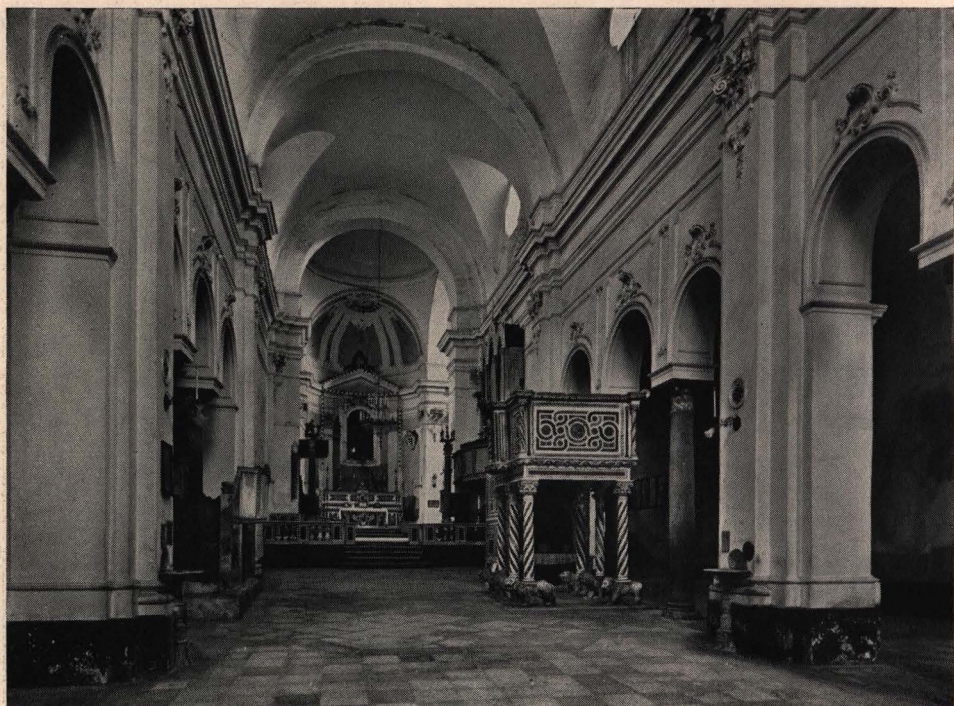
Fig. 99 - Interno del duomo di Ravello (secc. XI e XVIII). (fot. Anderson)
