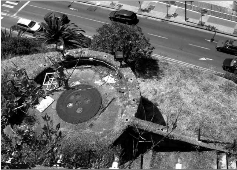
9. Piazzola per pezzo da 75mm prolungato nella parte anteriore di Forte la Carnale, alle spalle sono presenti due depositi per munizioni con pareti in cemento armato.
