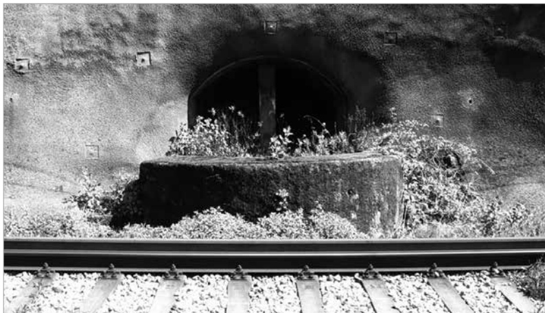
7. Postazione in caverna per arma anti-carro in barbetta, posta sulla Ferrovia Salerno-Napoli, all'altezza del caposaldo di Molina. Nella parte inferiore è presente una piccola camera sotterranea con scala a pioli per l'accesso diretto alla piazzola per l'arma (per gentile concessione dell'avv. Giuseppe Fienga).
