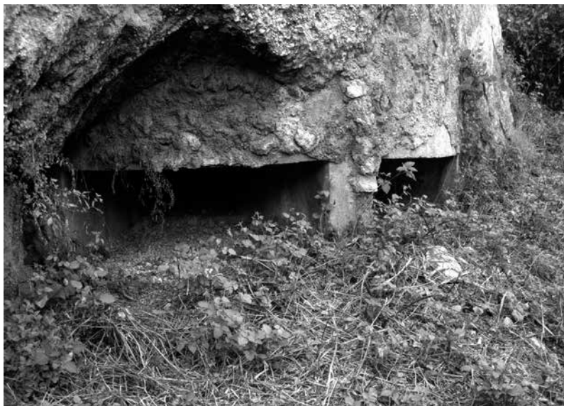
10. Postazione monoarma in caverna con mascheramento in pietra, posta nel lato nord/est di Forte la Carnale, a difesa del posto di blocco stradale del caposaldo di Santa Croce.
